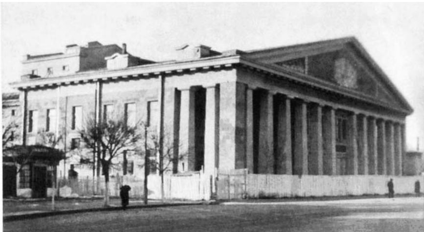
Строящийся Ворошиловградский областной драматический театр им. Островского
