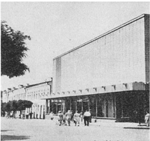
Здание филармонии до реконструкции
