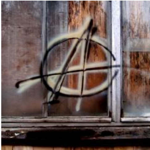
м. Свердловськ. Будівля швейної фабрики. Сфотографовано 02. 12. 12.
